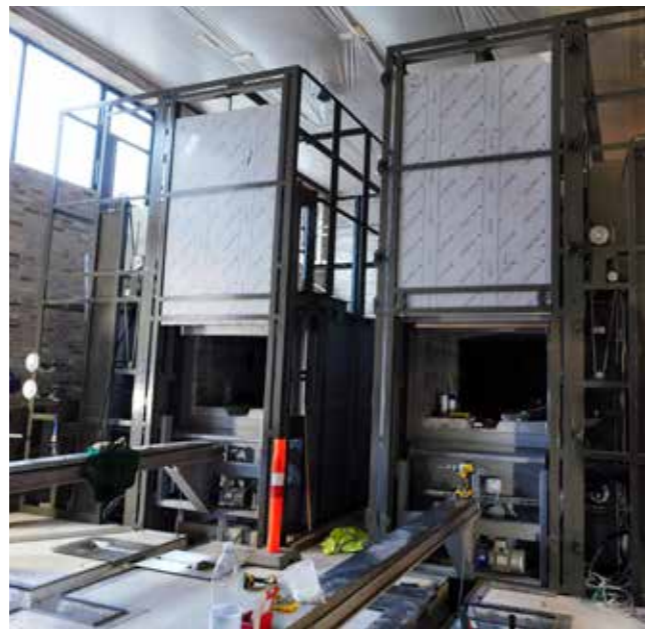
Det nye krematorium i Aabenraa får 2 ovnlinjer, med gas som brændsel. Taget bliver én stor solcelle, der er med til at reducere det samlede CO 2 regnskab.
