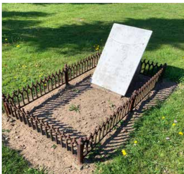
Pladen blev knust ved hærværk, men er nu repareret ved frivillig indsats. Støbejernsstakittet er rettet op og repareret.
